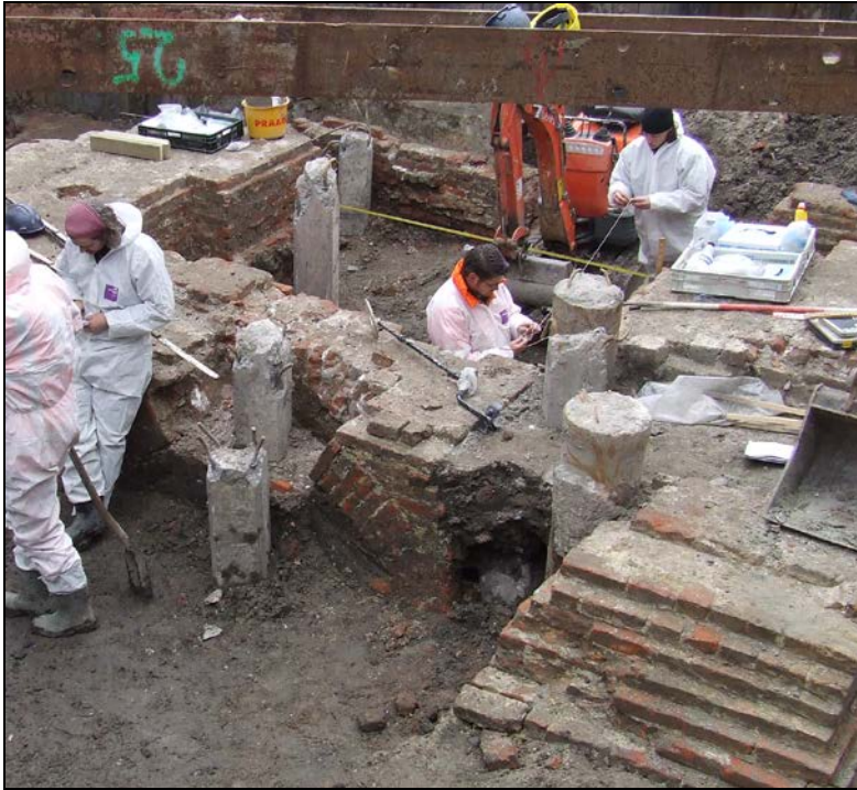
Afbeelding 28. Meerdere funderingspalen ter plaatse van de funderingen. Ter plaatse van de palen zijn grote stukken muur tot en met de onderzijde uitgebroken.
